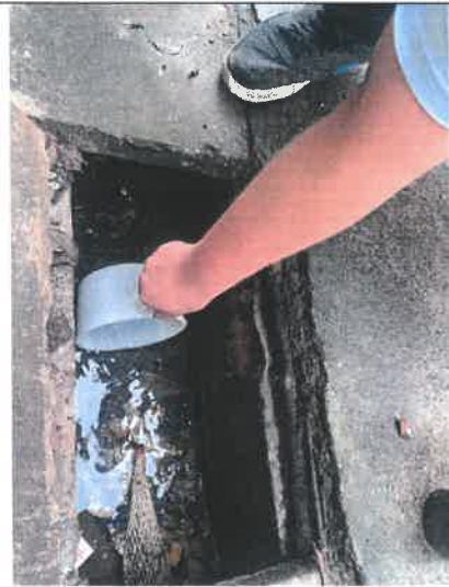
生活污水排放口
